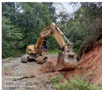
a. Pembuatan drainase jalan
