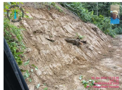
c. pembangunan terasering
