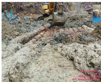
b. pembuatan bangunan jembatan
